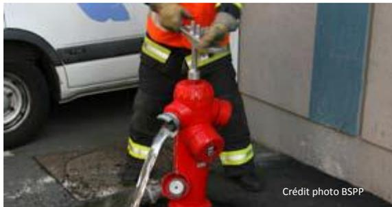
A la fin de l'intervention, les bouchons doivent être remis en place (à la main) mais sans les serrer avec la clef de poteau afin d'éviter que les lèvres de joints ne se détériorent.
