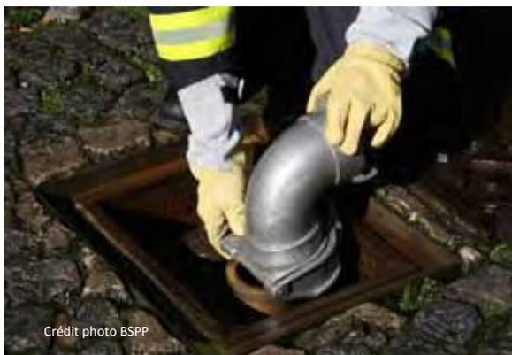
Placer l'orifice du coude d'alimentation dans la direction que doit prendre le tuyau mais à l'opposé ou latéralement à l'emplacement du carré de manœuvre ;
