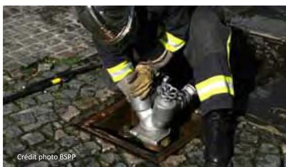
Placer les tubulures dans la direction que doivent prendre les tuyaux mais à l'opposé ou latéralement à l'emplacement du carré de manœuvre ;
