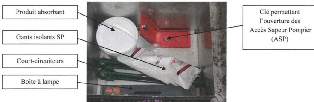
Photo trappe de quai
