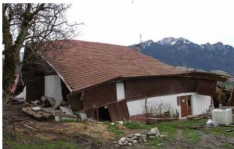
Les bâtiments, s'ils peuvent résister à de petits déplacements, subissent une fissuration intense en cas de déplacement de quelques centimètres seulement. Les désordres peuvent rapidement être tels que la sécurité des occupants ne peut plus être garantie et que la démolition reste la seule solution.
