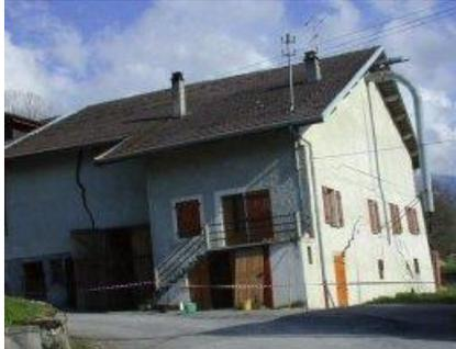
**Les tassements et les affaissements :** certains sols compressibles peuvent se tasser sous l'effet de surcharges (constructions, remblais) ou en cas d'assèchement (drainage, pompage). Ce phénomène est à l'origine du tassement de sept mètres de la ville de Mexico et du basculement de la tour de Pise.
