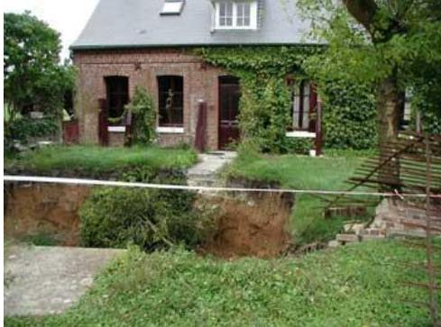
**Les effondrements de cavités souterraines :** l'évolution des cavités souterraines naturelles (dissolution de gypse) ou artificielles (carrières et ouvrages souterrains) peut entraîner l'effondrement du toit de la cavité et provoquer en surface une dépression généralement de forme circulaire.
