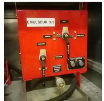
Système de pré-mélange à contrôle manuel.
