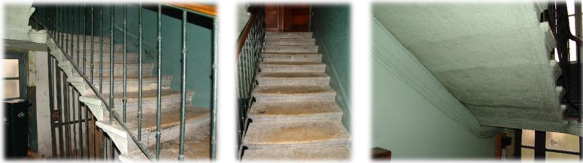
Exemple d'un escalier en pierre dans un immeuble d'habitation
