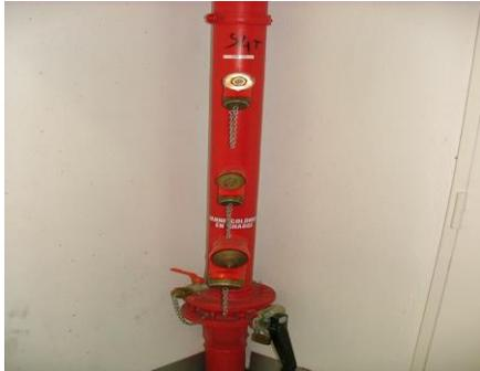
Les colonnes en charge sont des tuyauteries fixes et rigides installées obligatoirement dans les immeubles de grande hauteur de plus de 50 mètres, reliées à des réservoirs, à des pompes, à des surpresseurs ou à tout autre dispositif permettant d'alimenter les lances des sapeurs-pompiers.
