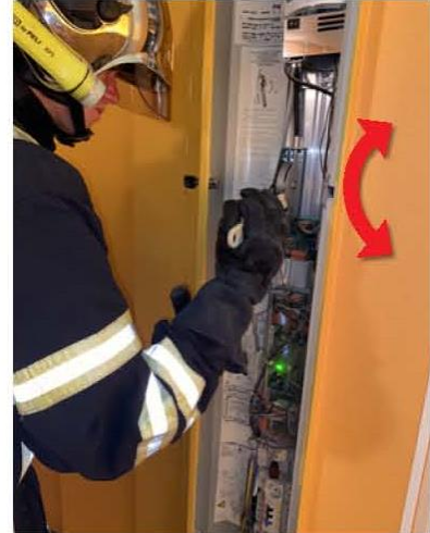
Pompage à l'aide du levier.
