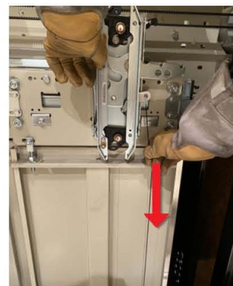
2e possibilité Déverrouiller le système mécanique en tirant sur la câblette. Ouvrir en parallèle les portes.
