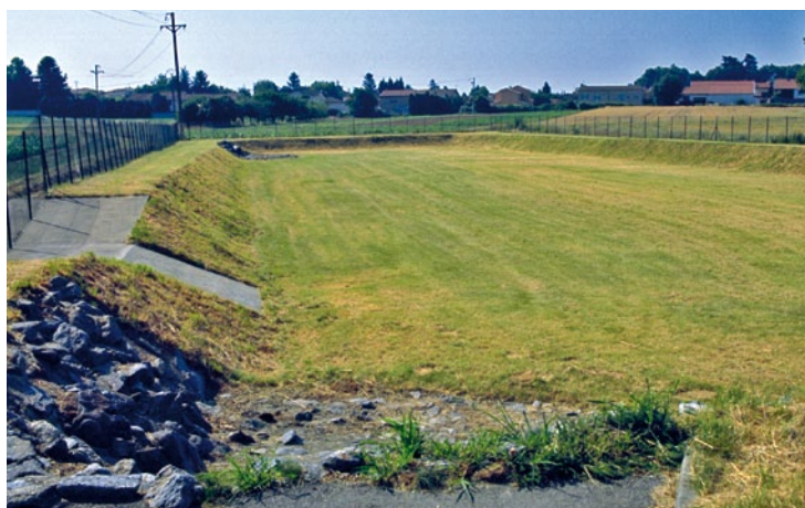
Bassin de rétention de Sathonay-Village
